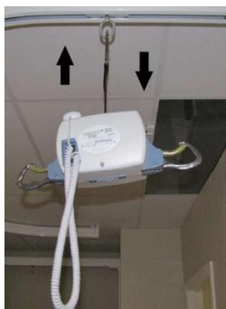
写真1 - 上昇/下降ボタンを押すと、ハンガー（本体）はストラップと共に、上下に移動します。
