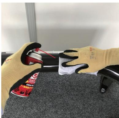
潤滑剤を塗布することで、レールに付着した汚れが簡単に落ちると同時に、レールと昇降機が擦れる音が軽減されます。
